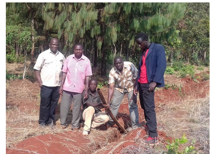
Die Plastikrohre werden über 6 km lang ca. 80 cm tief verlegt und haben mittlerweile die Baustelle erreicht
